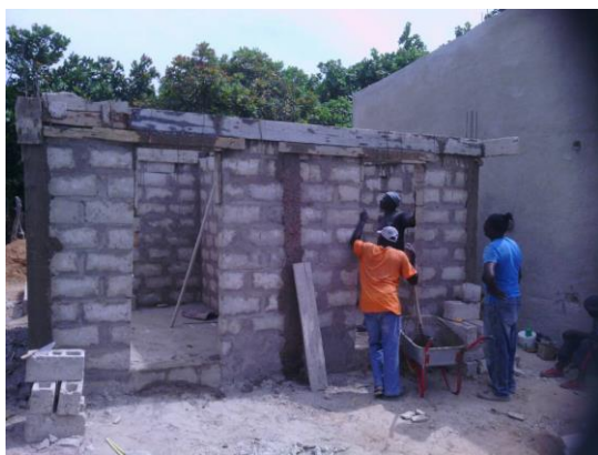
Toiletblok in aanbouw
